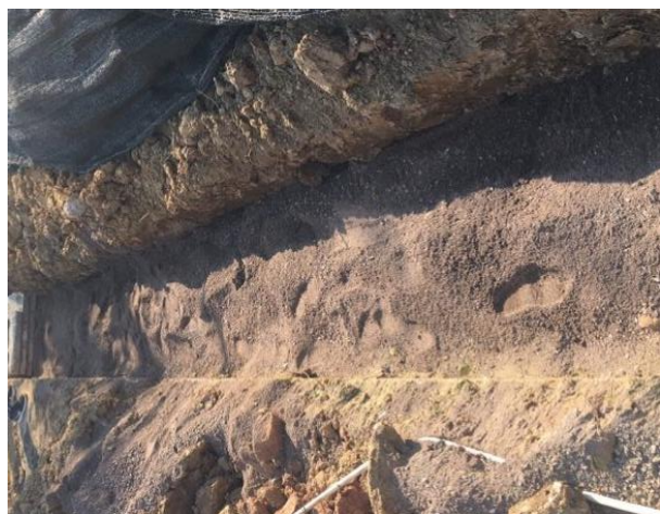
砖砌排水沟施工
