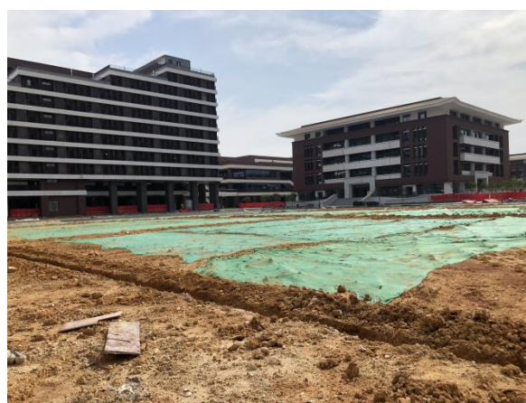
塑料彩条布苫盖+砖砌沉沙池
